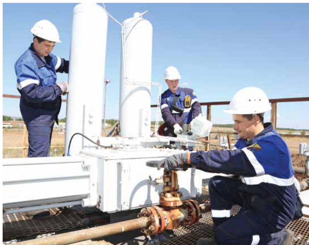
Работники дожимной компрессорной станции № 2 газопромислового управления Виталий Черненко (слева), Алексей Коптев (в центре) и Дмитрий Филин готовят оборудование к подключению перемычки
