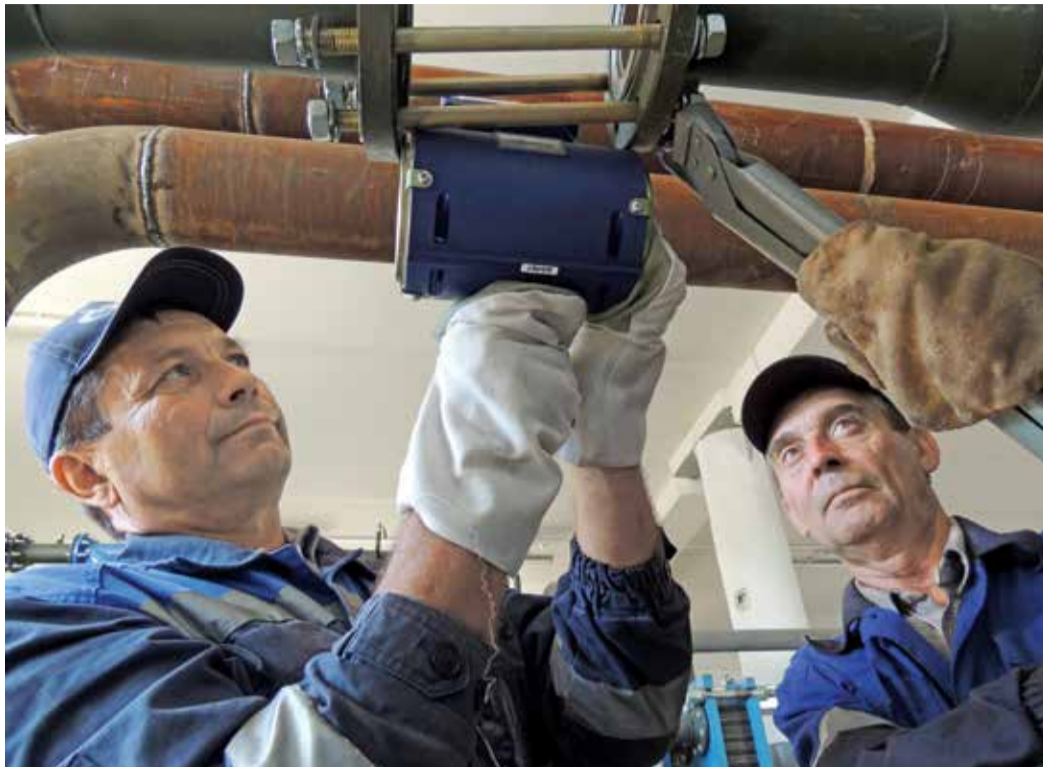
Слесари-сантехники УЭСП Василий Заруцкий (слева) и Николай Лушников ведут монтаж прибора учета тепловой энергии
