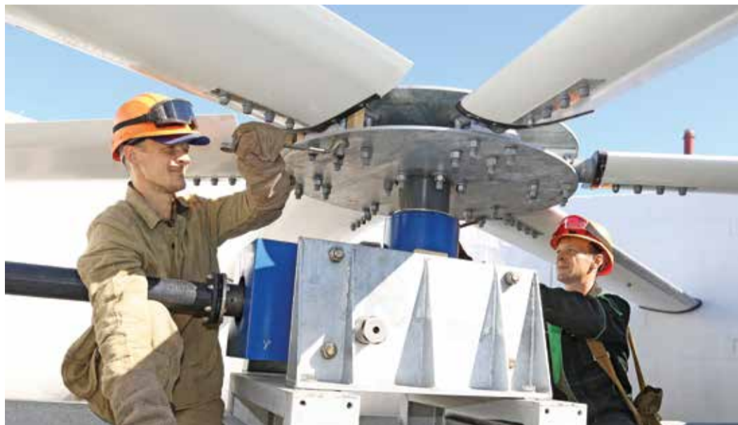
Электрогазосварщики Николай (слева) и Петр Бочкаревы ведут монтаж вентилятора градирни
