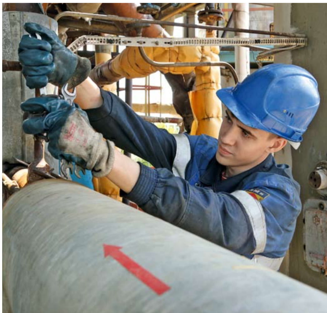
Оператор технологических установок Никита Болучевских проводит ревизию манометрической сборки
