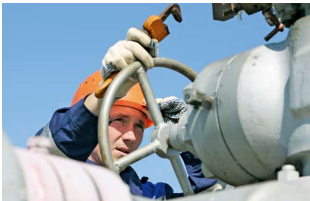
Замер давления на устье скважины выполняет Андрей Симонов (второе место)
