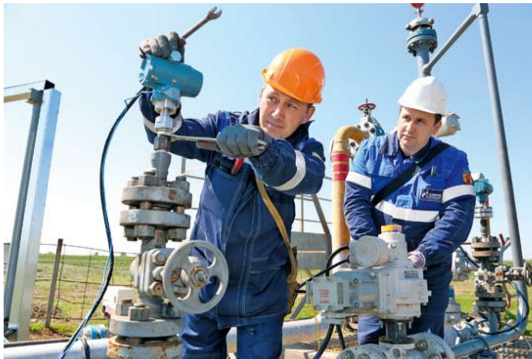
Оператор по добыче нефти, газа и конденсата Виталий Колбасов и мастер Андрей Антитин ведут монтаж электроприводной задвижки
