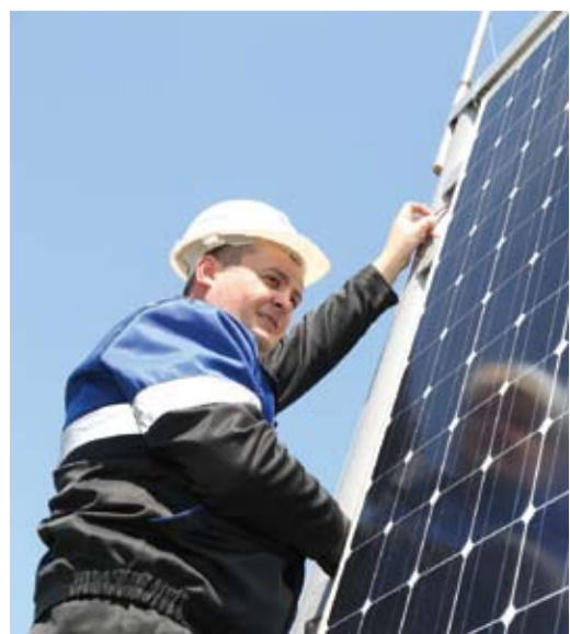
Монтаж солнечной батареи ведет Михаил Кулемин
