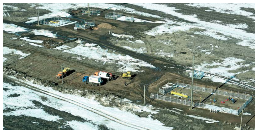
Бригада Нижнепавловского ЛПУ переводит транспорт продукта с II в IV нитку конденсатопровода Оренбург — Салават
