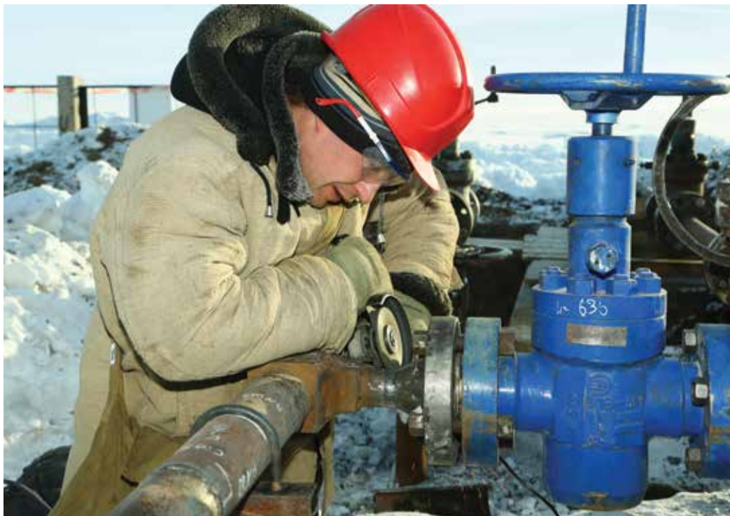
Слесарь-монтажник технологических трубопроводов Виктор Синельников ведет обработку сварных стыков
