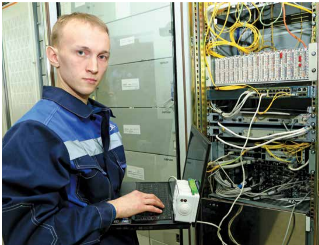
Ноу-хау инженера электросвязи Сергея Бойкова позволяет контролировать работу оборудования
