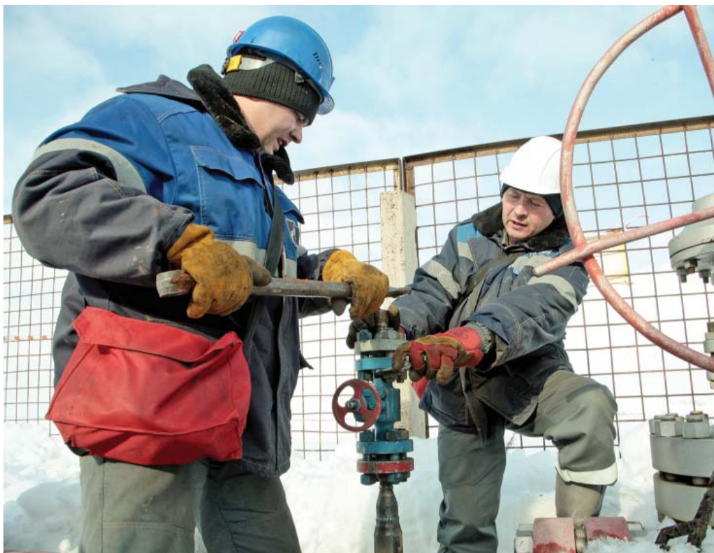
Денис Бакиров и Алексей Данилов выполняют сборку фланцевого соединения
