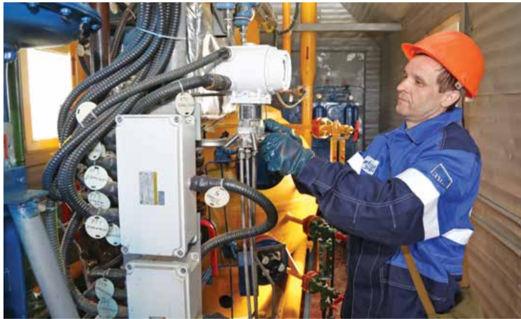
Оператор по исследованию скважин Александр Барышев ведет осмотр оборудования
