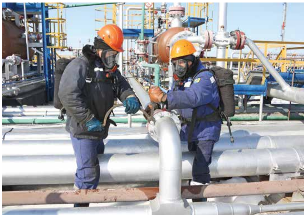
Идет отглушка факельной линии
