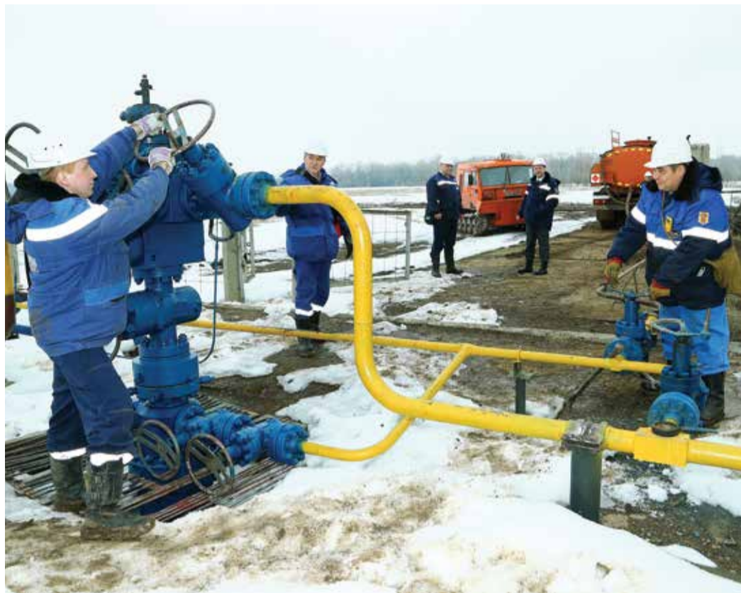
Бригада Шамиля Агишева ведет тепловую обработку скважины № 14012н
