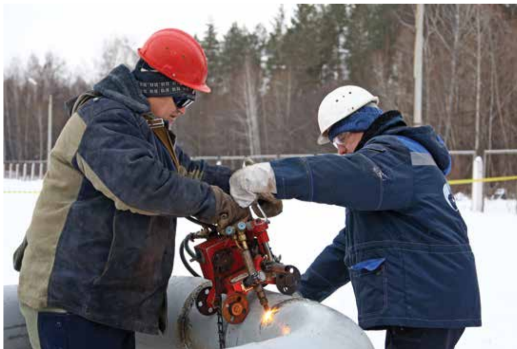
Газорезчик Александр Семенов (слева) и монтажник Алексей Шеин вырезают дефектный участок
