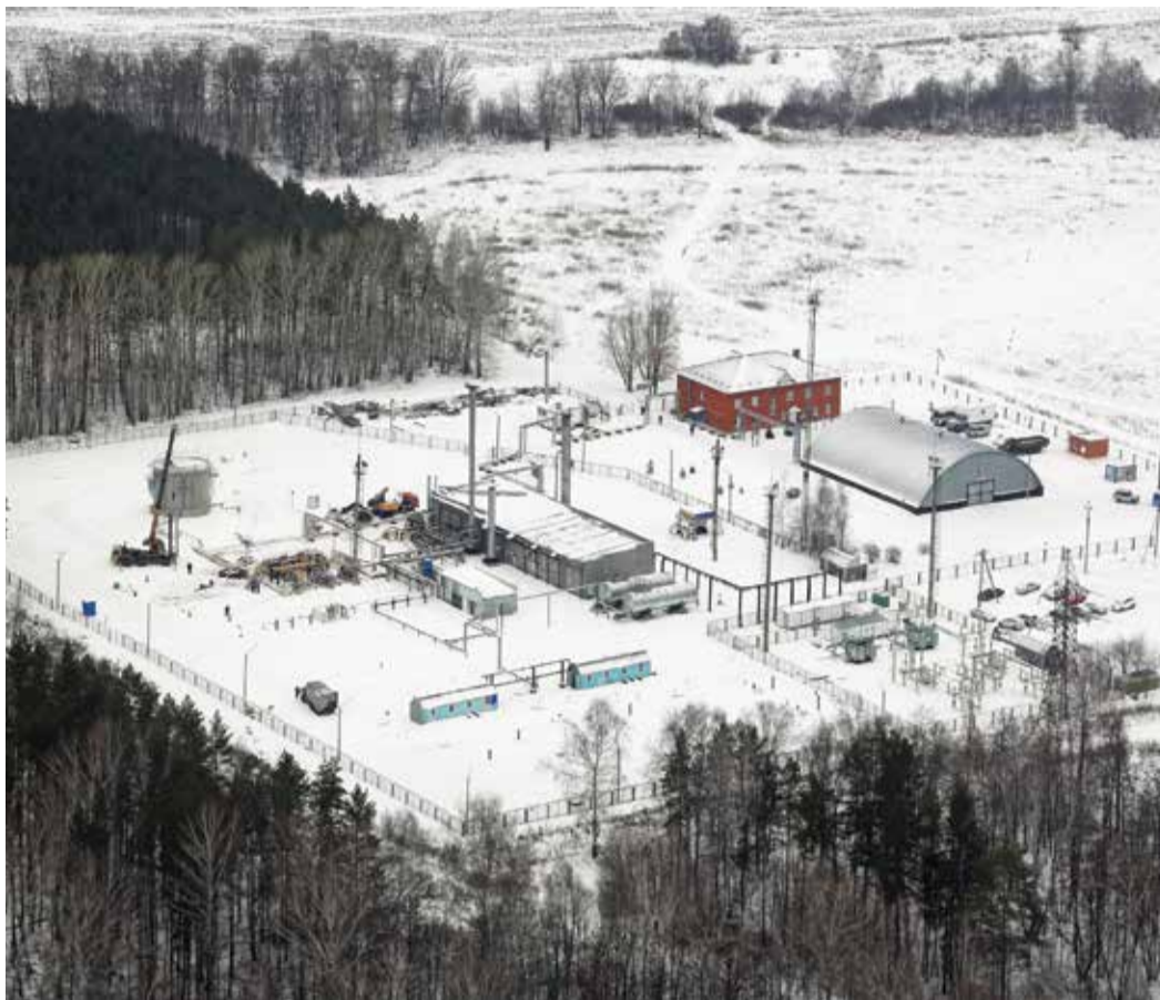
Насосная станция «Подлесное» с высоты птичьего полета
