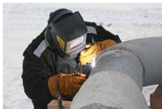
Сварщик Николай Мельников ведет монтаж катушки
