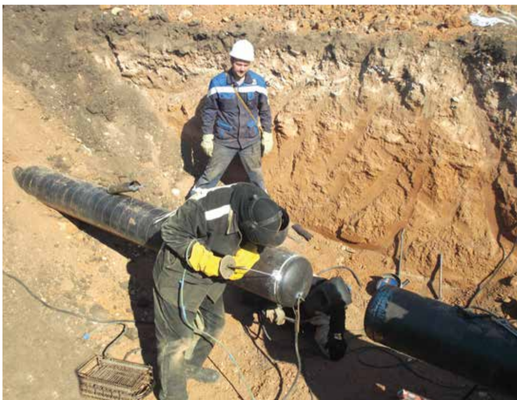
Идет монтаж сферических заглушек
