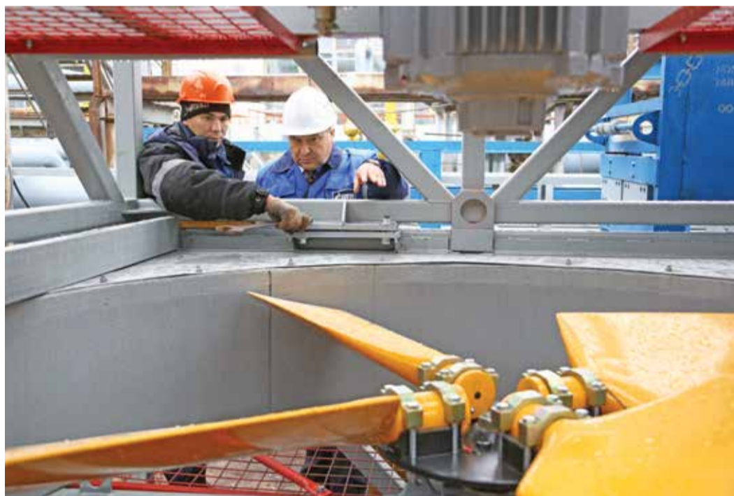
Ведется подготовка к демонтажу блока вентиляторов
