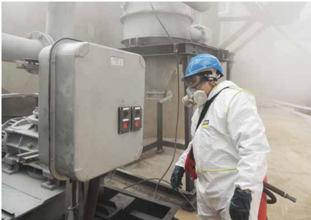
За секунду до этого машинист Руслан Аккубаков запустил пневматический подъемник. Выгрузка отработавшего катализатора началась
