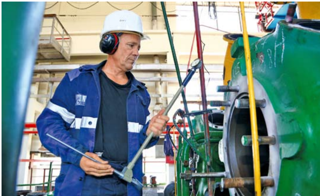
Проверяется износ цилиндра компрессора
