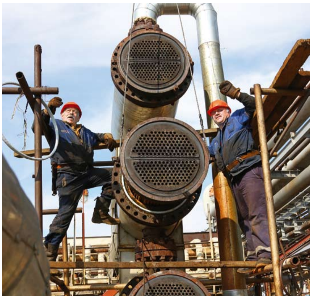
Ведется сборка теплообменника на установке У-192 газоперерабатывающего завода
