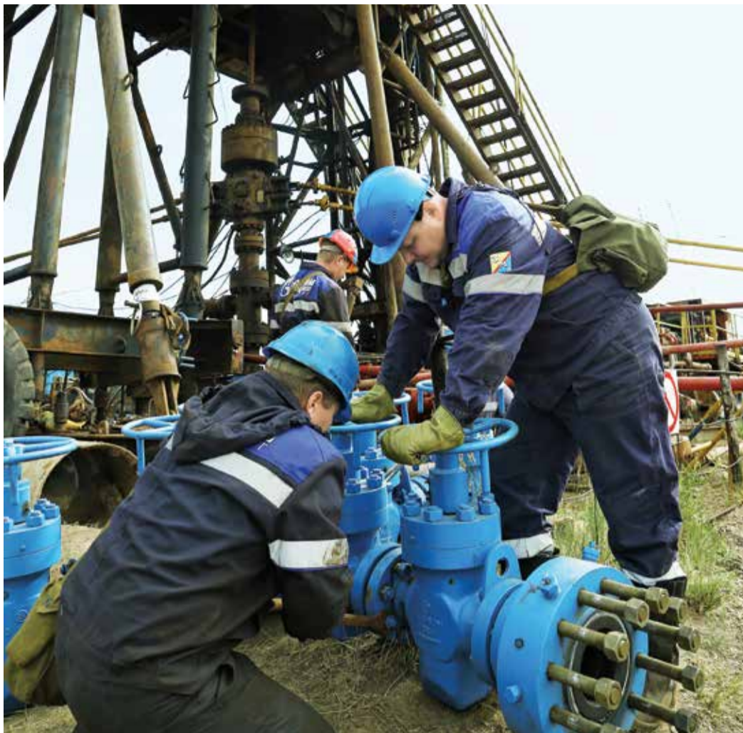
Ведется осмотр фонтанной арматуры перед установкой на устье скважины
