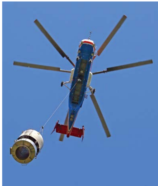
Поднять 3-тонный оголовок на 100-метровую вершину факела удалось только вертолетом
