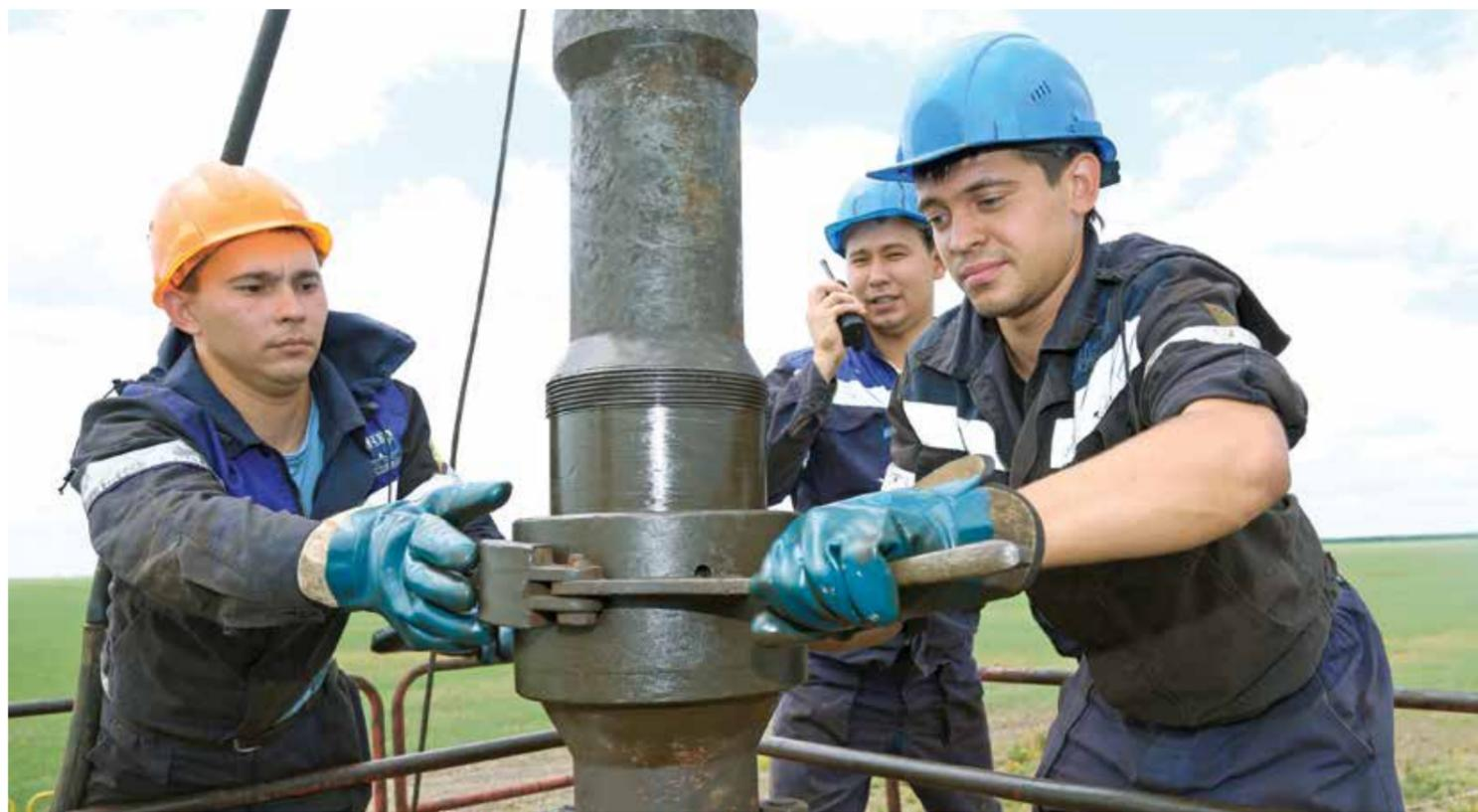
Помощники буровика Сергей Бузанов, Искандер Жалмухамбетов, слесарь Евгений Просветов ведут монтаж оборудования для спуска гибкой трубы
