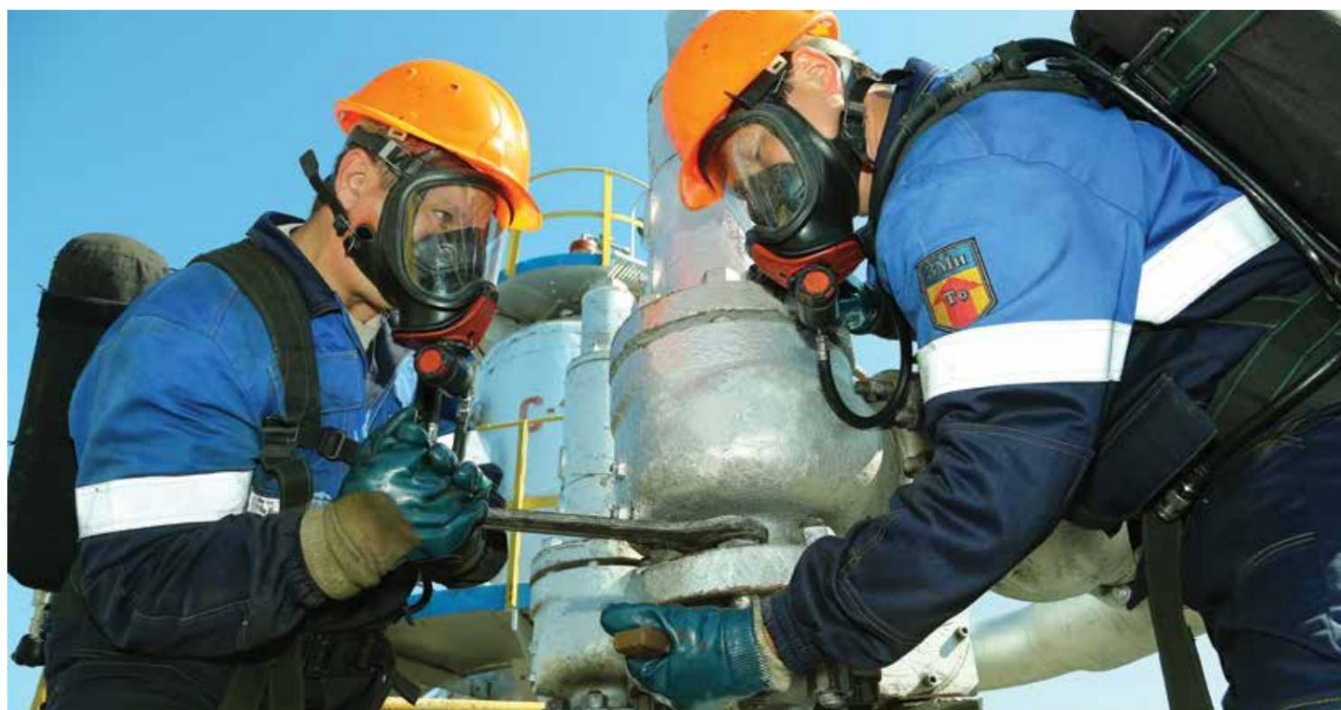
Первая технологическая линия отключена. Но правила требуют выполнять разбор оборудования в защитных масках. Газоспасатели Эльнар Камалутдинов и Сергей Каширин демонтируют проглушки для пуска линии в работу
