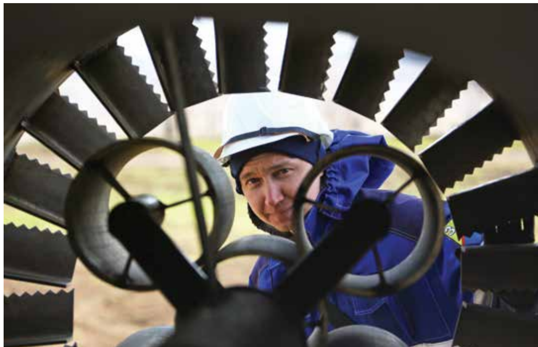
Зубчатые лопасти нового оголовка факела закручивают воздушные потоки, усиливая их. Механик Наиль Сатлыков осматривает оборудование перед подъемом
