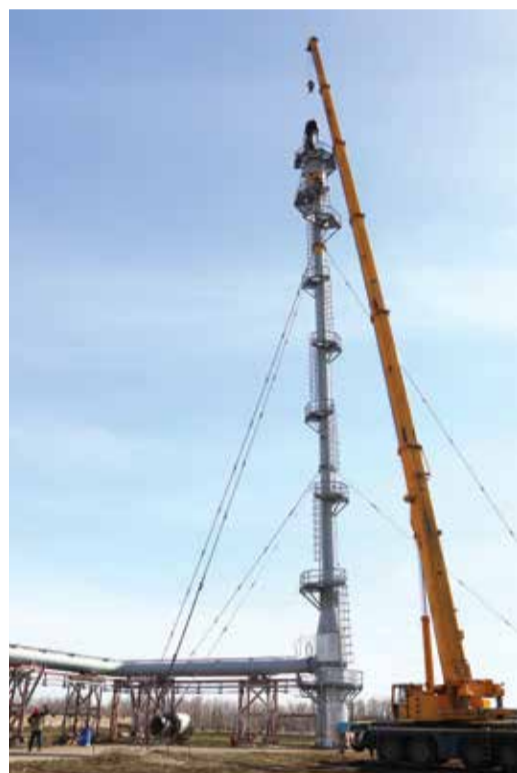
Оголовок заменен при помощи крана
