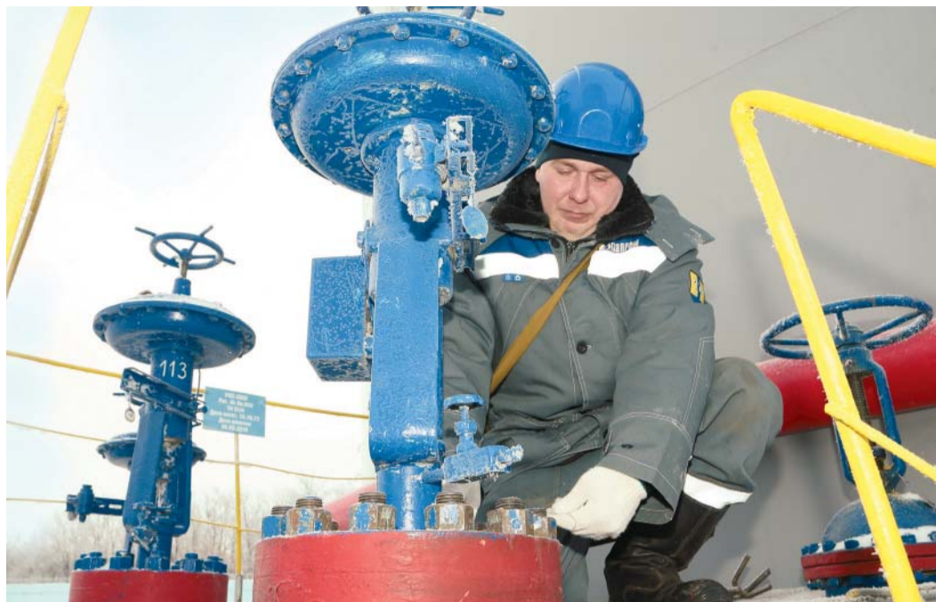
Слесарь-ремонтник Вячеслав Прохоров ставит пробку на фланцевое соединение
