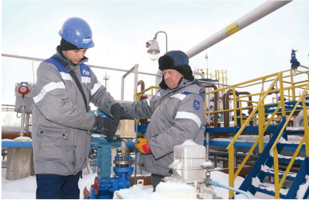
Слесари КИПиА Александр Минеев и Дмитрий Елин монтируют датчик давления
