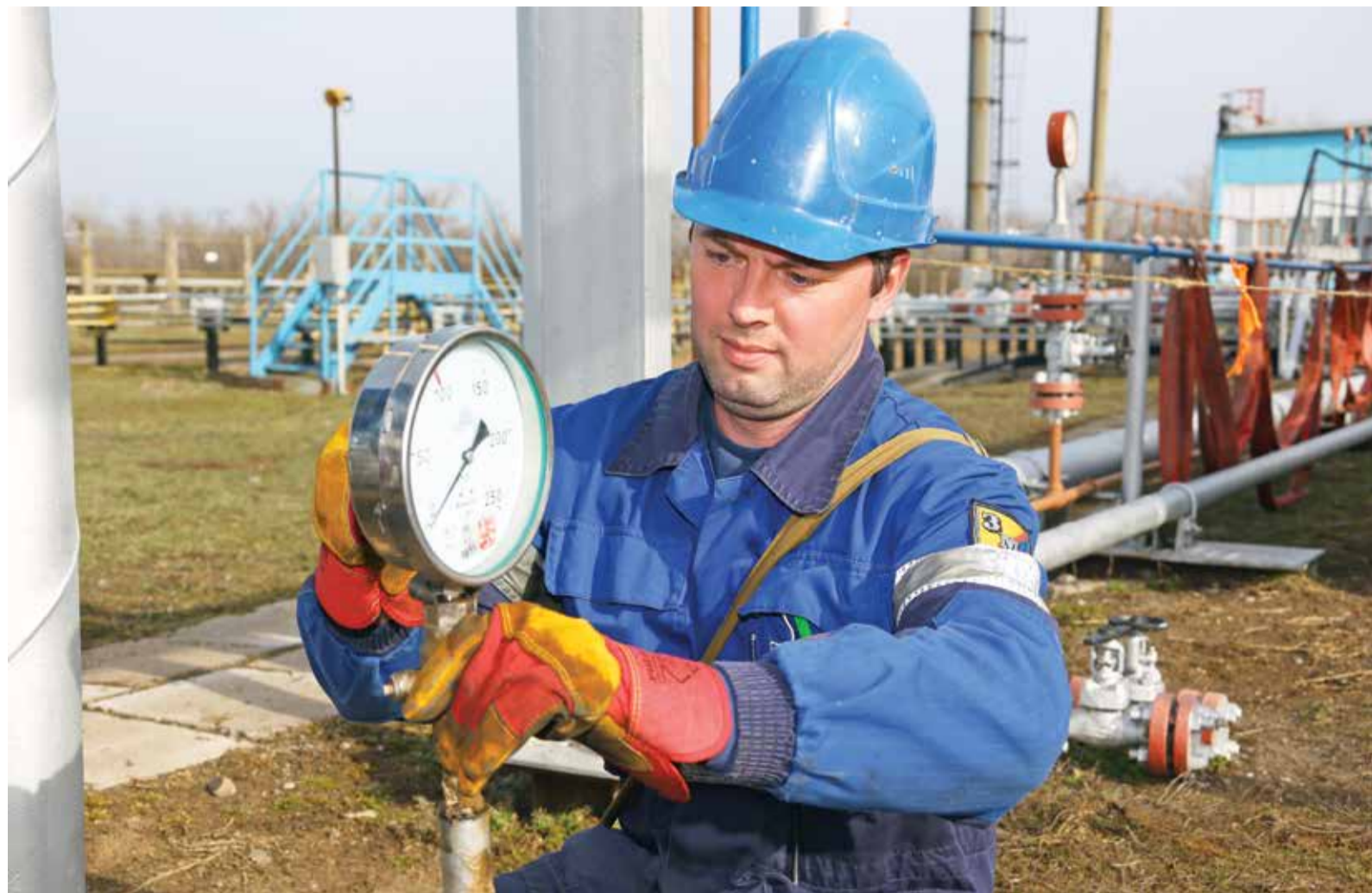
За несколько часов до пуска. Ренат Габдулгафаров устанавливает манометр
