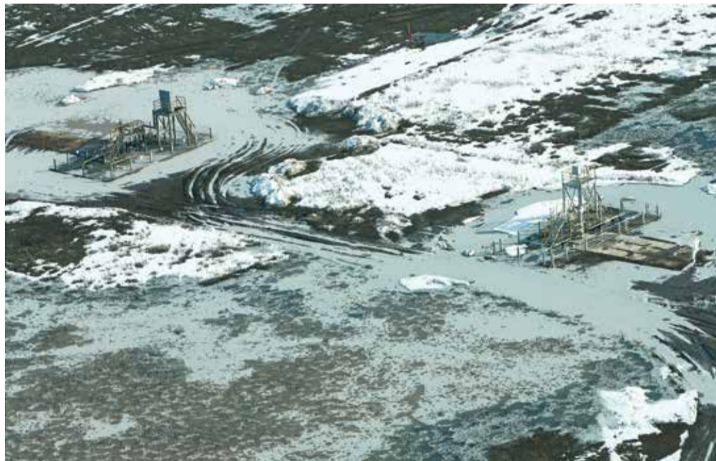
Вертолетный облет позволяет оценить обстановку на производственных объектах
