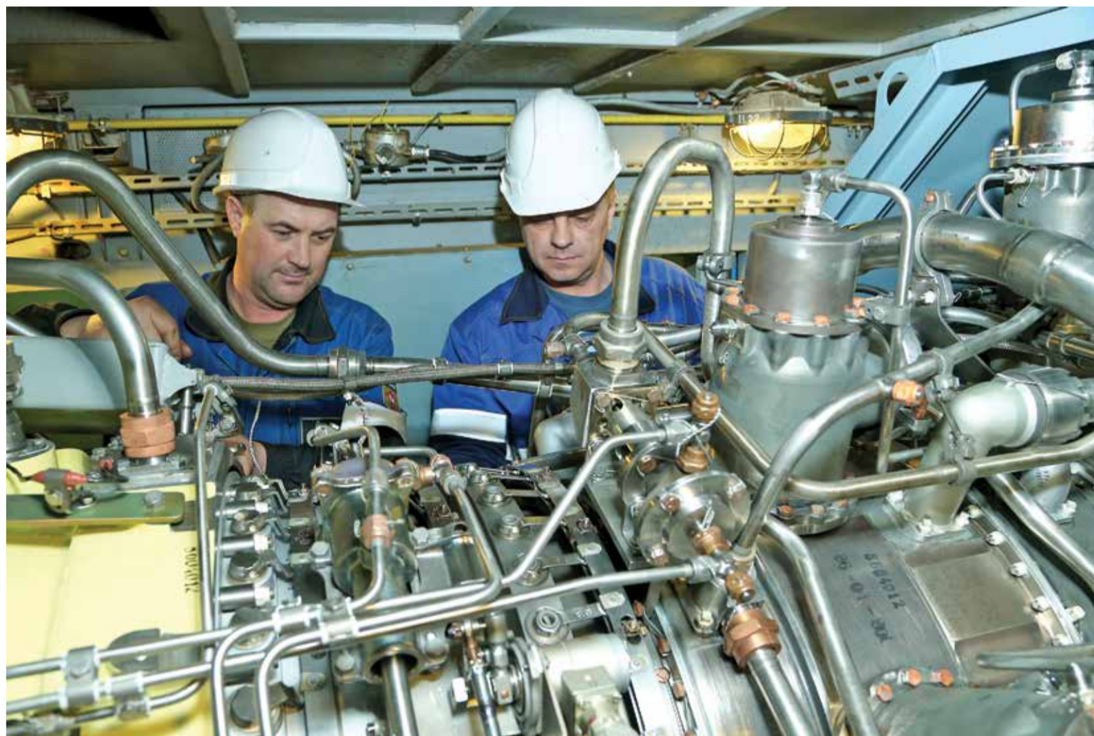
Выполняется обвязка газотурбинного двигателя на газоперекачивающем агрегате № 5 ДКС-3
