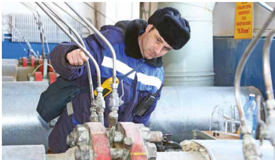
Ремонт на замерном узле облегчит эксплуатацию оборудования и улучшит экологию
