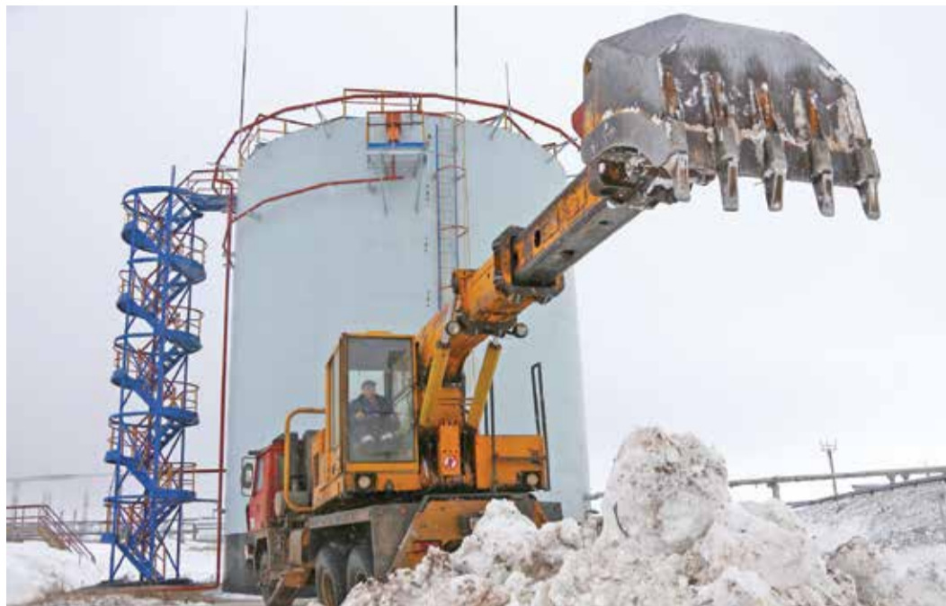
К работе в паводок все объекты завода готовы
