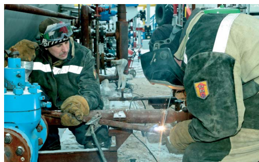
Слесарь Григорий Иноземцев и электросварщик Дмитрий Мусс ведут огневые работы на линии подачи воздуха к оборудованию КИПиА
