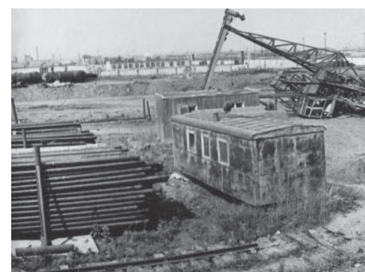
Начало строительства нового склада. 1968 год
