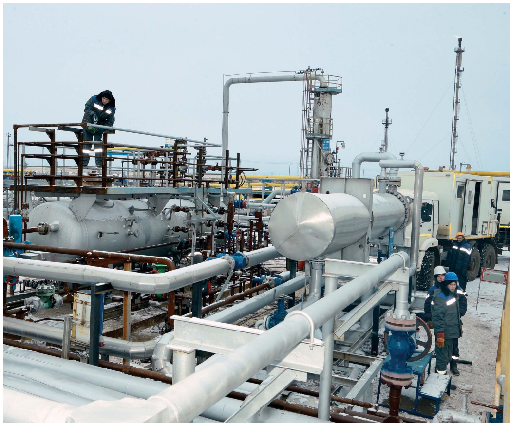
На площадке обслуживания монтируется линия ингибирования сепаратора
