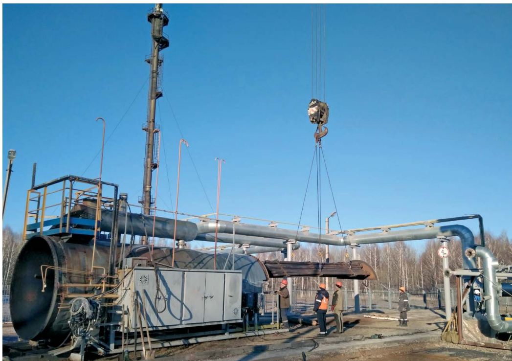
Сборка подогревателя ГП 1551 после проведенной диагностики
