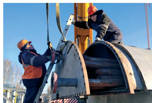
Монтаж змеевика этана в корпус подогревателя
