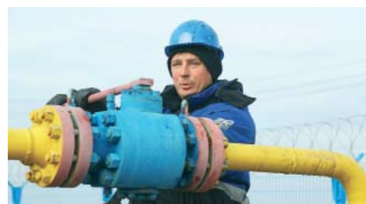
Александр Пирогов открывает кран на линии подачи газа в камеру для пуска очистного устройства
