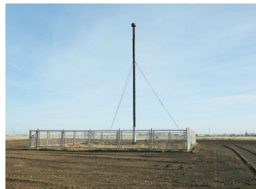
В УЭСП — 45 продувочных свечей, предназначенных для безопасного сжигания газа
