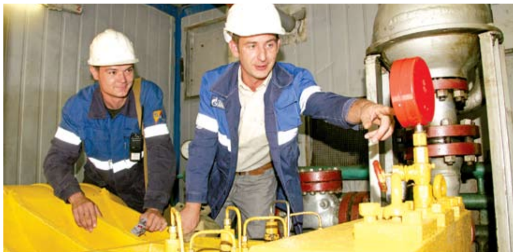
Ведется осмотр насоса
