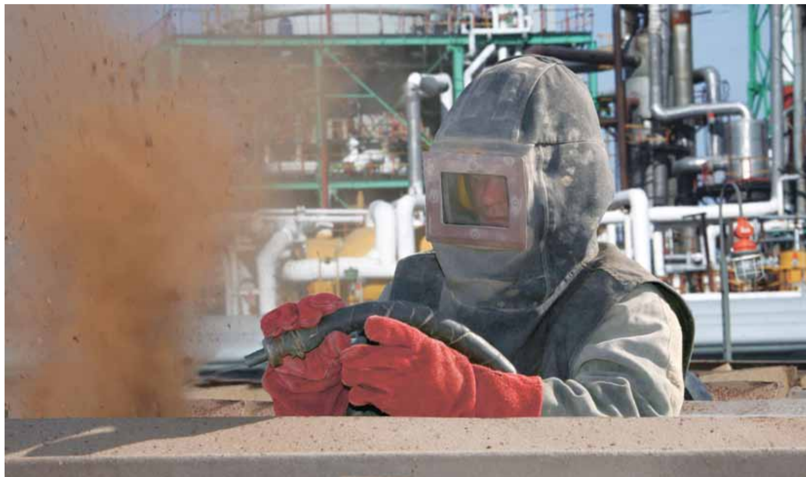
Идет очистка оборудования на пропано-холодильной установке
