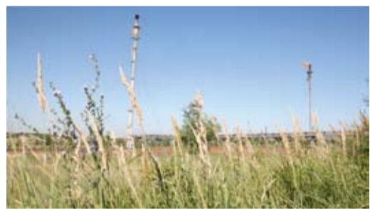
Факелы гелиевого завода оснащаются оголовками нового поколения
