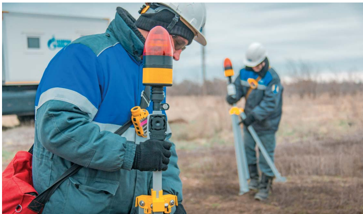
Трубопроводчики линейные Алексей Андреев и Александр Чеканин устанавливают периметральное ограждение
