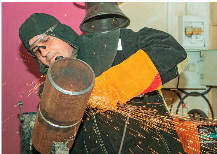
Константин Ходарев после сборки катушки проводит зачистку прихваток
