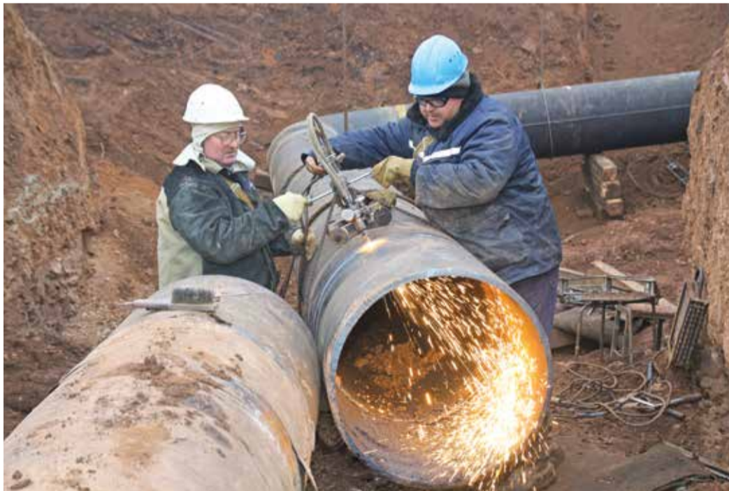
Идут огневые работы
