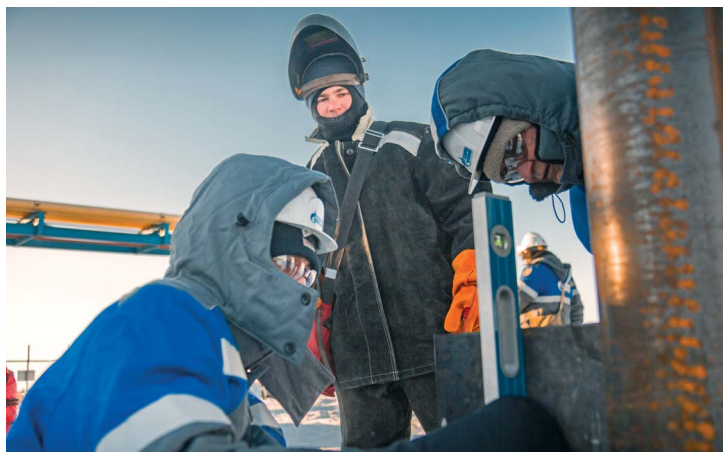
Специалисты управления аварийно-восстановительных работ (УАВР) ведут монтаж опорных конструкций
