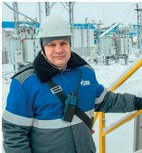
У новой подстанции ДКС-2
