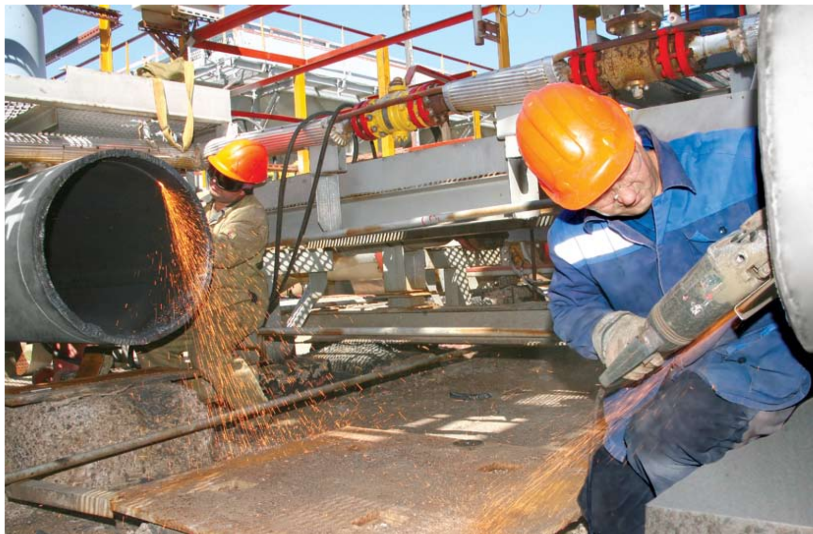
Здесь будет новый кран
