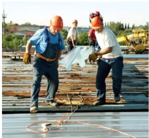
Ведется ремонт кровли на боксе технического обслуживания автомобилей
