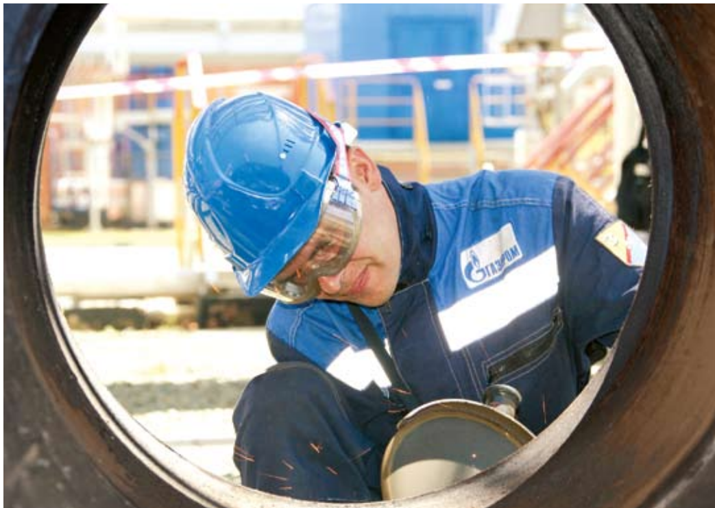
Идет шлифовка кромки будущих сварочных соединений
