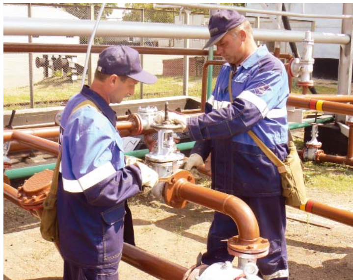
Роман Меженский (справа) с Владимиром Макухиным выполняют обслуживание оборудования. 2015 год
