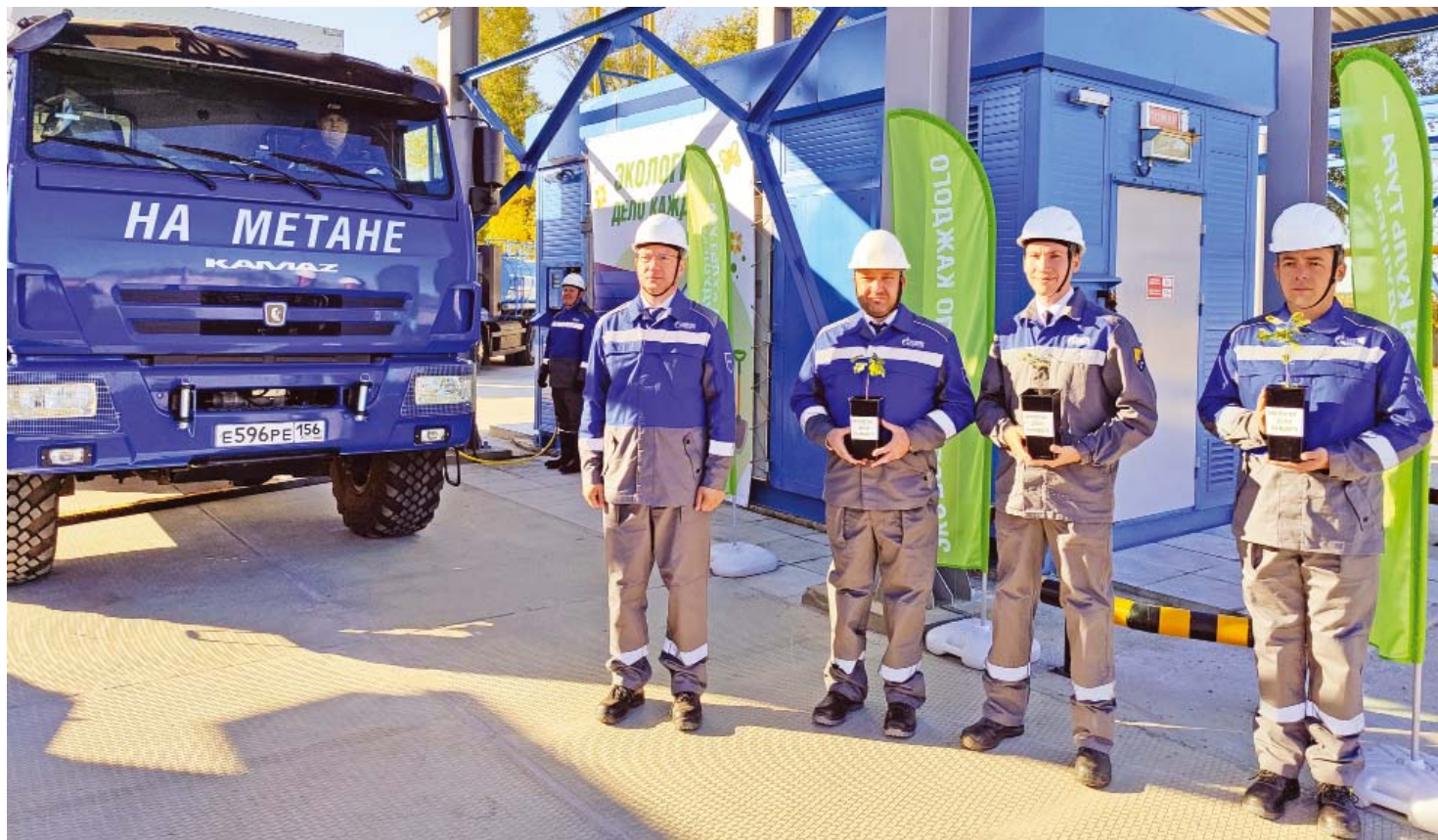
Пуск новой автомобильной газонаполнительной компрессорной станции в селе Октябрьское
