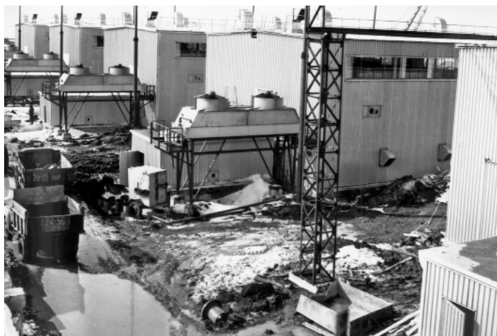
Строительство первого цеха ДКС-1. 1982–1983 годы
