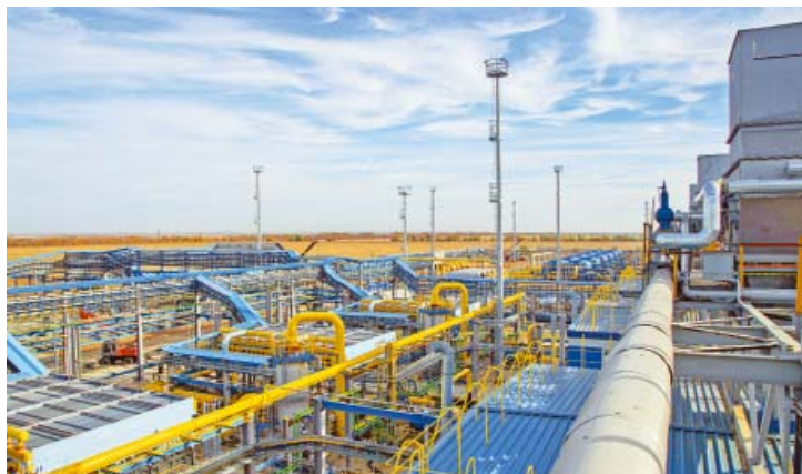
Реконструкция ДКС-2 повысит надежность работы дожимного комплекса
