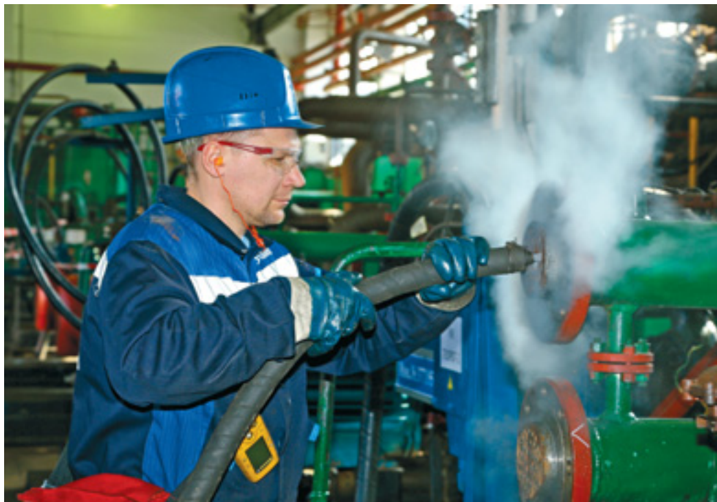
Машинист Михаил Чернов проводит продувку паром теплообменного оборудования
