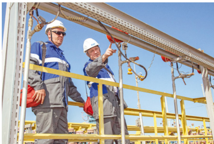
Начальник оперативно-производственной службы № 1 газопромыслового управления Общества Владимир Кондрахин и заместитель начальника отдела Департамента ПАО «Газпром» Андрей Тимофеев проверяют параметры скважины
