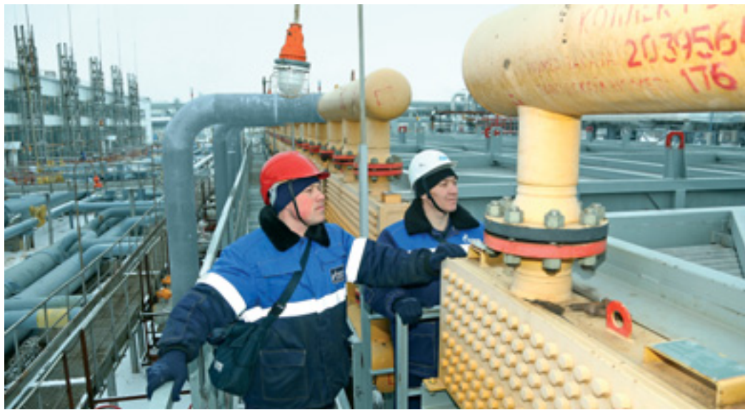
Машинисты технологических компрессоров Александр Тимофеев и Алмаз Жаукимбаев проводят осмотр аппаратов воздушного охлаждения
