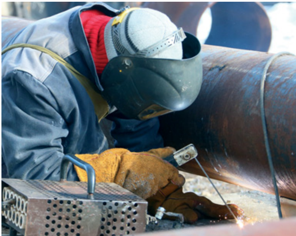
Слесарь-сварщик Алексей Гамов выполняет монтаж опорной конструкции трубопровода
