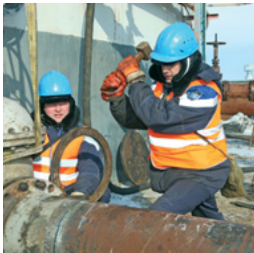
Операторы товарные Алексей Самолюк и Арсений Маликов ведут установку запорной арматуры
