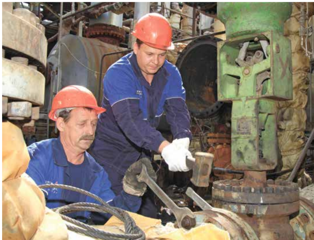
Идет ремонт установки
