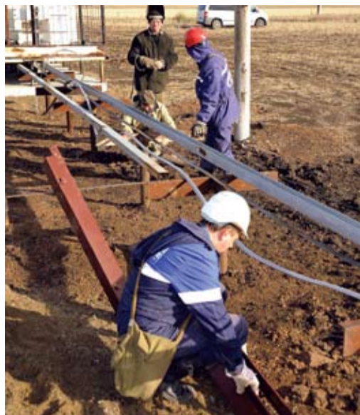
Идет монтаж кабельной линии
