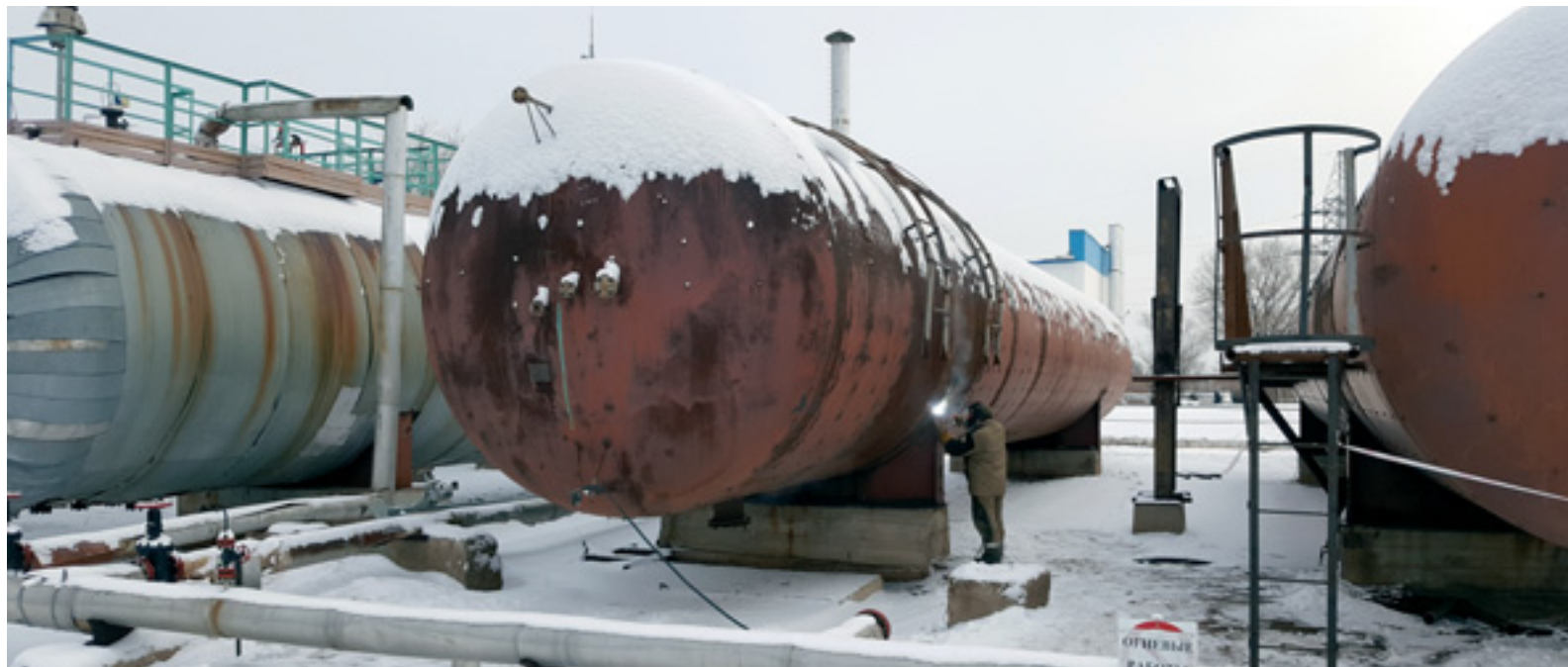
Сварщик Евгений Казарин приваривает емкость к опорам
