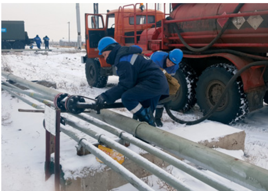
Трубопроводчик линейный ЛЭС ГПУ Дмитрий Дубинин и машинист промывочного агрегата УТТСТ Евгений Рукин подключают «кислотник» к трубопроводу. На заднем плане — работники ЛЭС готовятся к подогреву трассы с помощью пароперемещаемой установки
