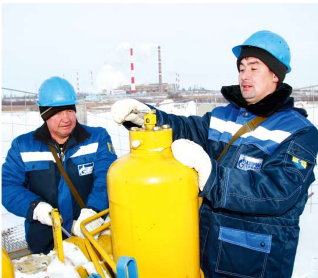
Мороз ремонту не помеха
