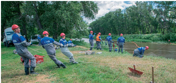
Газоспасатели устанавливают боновые заграждения
