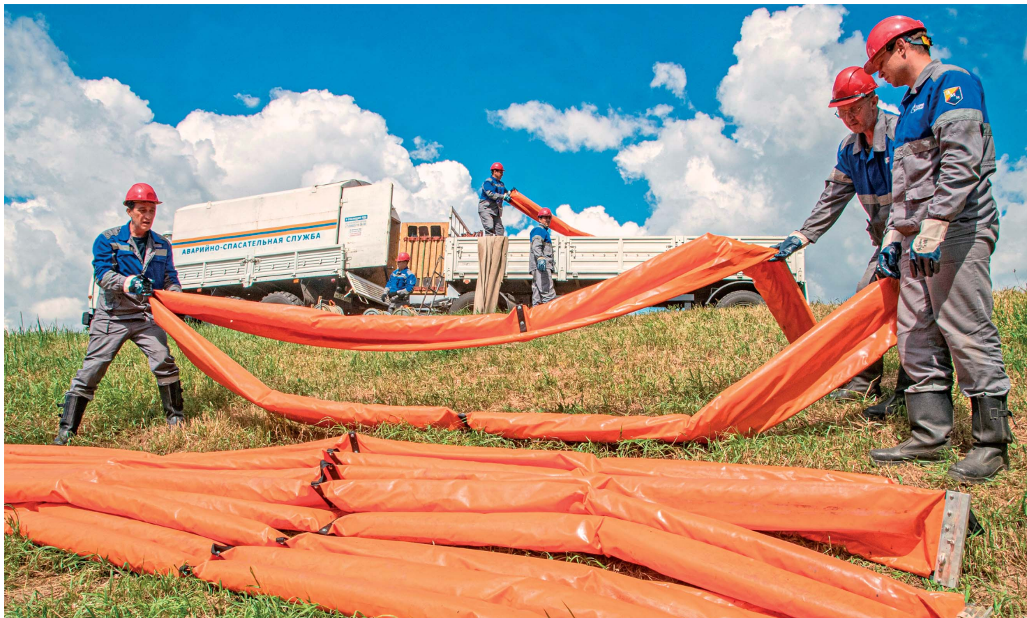
Ведется подготовка к установке боновых заграждений — барьера, локализирующего нефтяной разлив на водной поверхности
