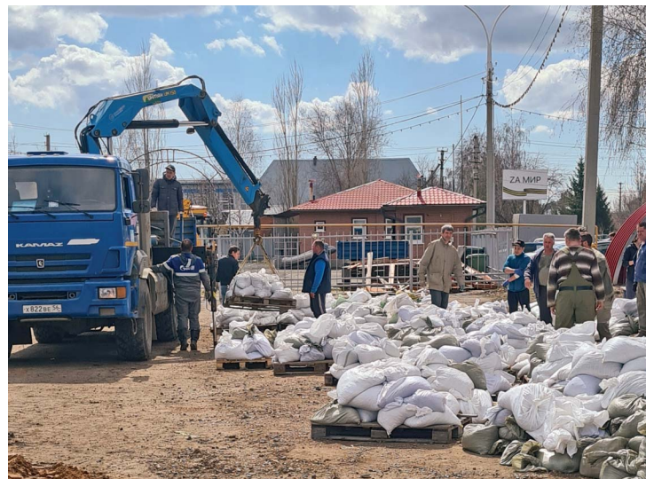
Строительство дамбы в селе им. 9 Января
