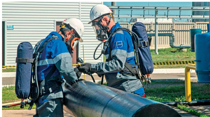
Представители Октябрьского ЛПУ устанавливают герметизирующее устройство
