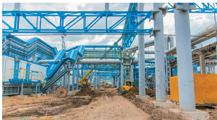
Завершаются работы по сооружению межцеховой эстакады
