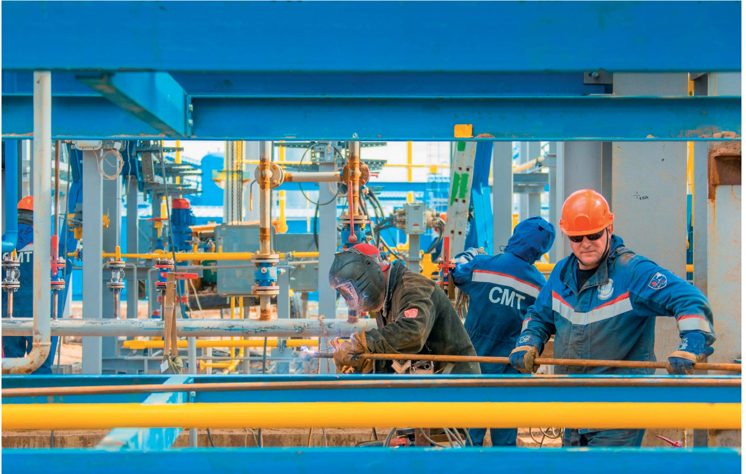
Сварочно-монтажные работы на установке подогрева конденсата цеха № 1 ДКС-2
