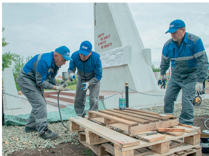
Подготовка к покраске ограждения
