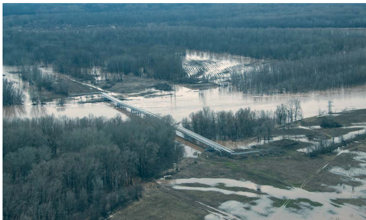
Воздушный переход Западного коридора трубопроводов (1 очередь) через реку Урал
