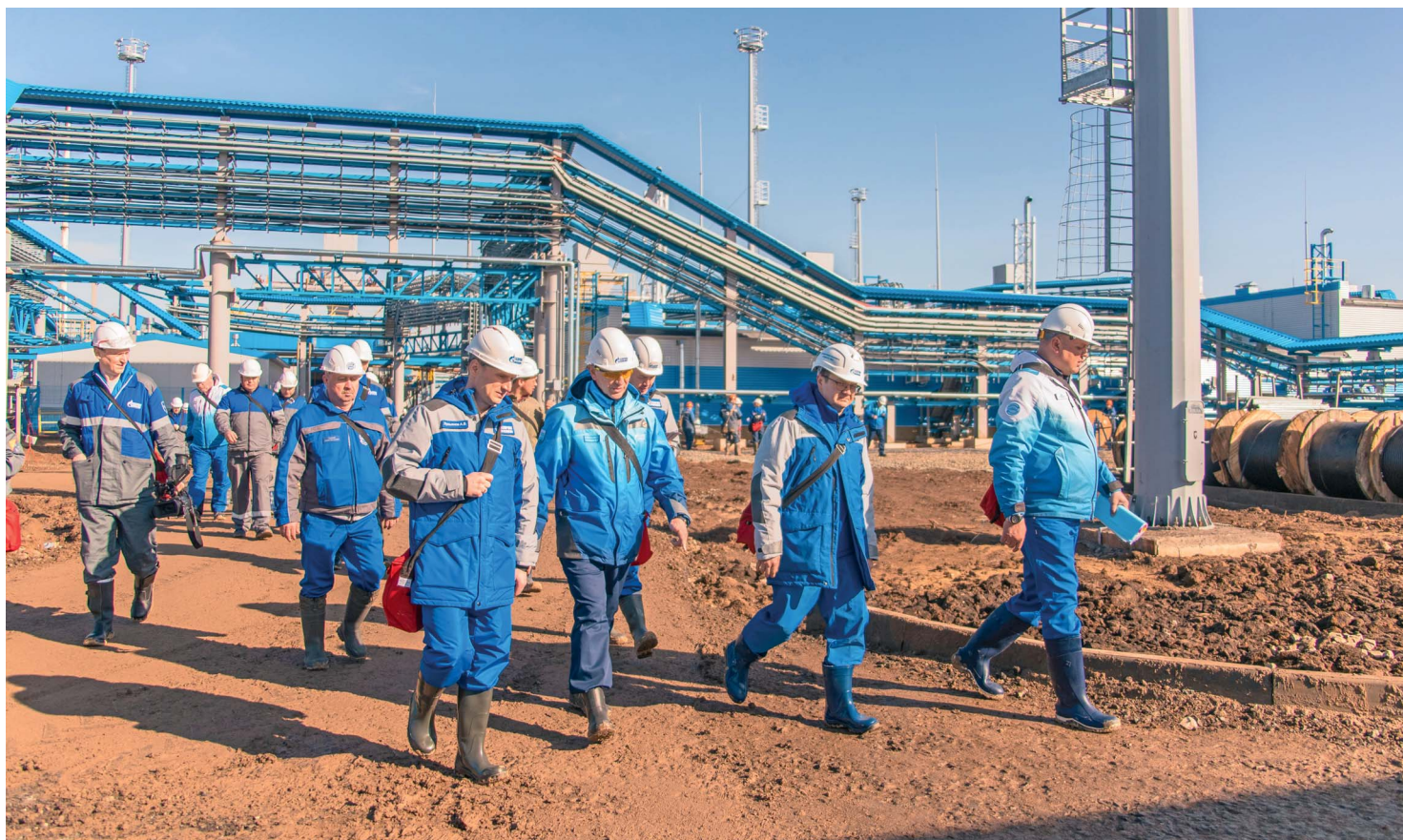
Участники совещания ознакомились с ходом работ по реконструкции ДКС-2
