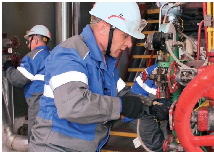
Слесари по ремонту оборудования котельных и пылеприготовительных цехов ГПУ демонстрируют свое мастерство (на первом плане победитель конкурса Сергей Слободсков)
