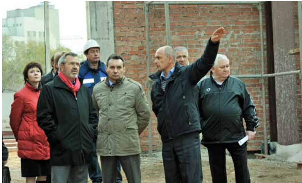
Сергей Иванов на строящемся Федеральном центре настольного тенниса
