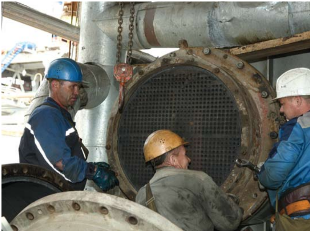
На установках первого цеха газоперерабатывающего завода идут ремонтные работы
