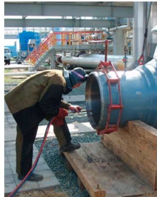
Подготовка к монтажу запорного крана
