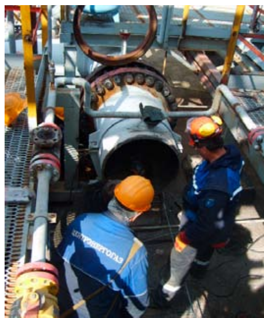
Монтаж запорного крана задача сложная
